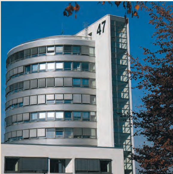
Von links: Gebäude 47 in Kaiserslautern,
