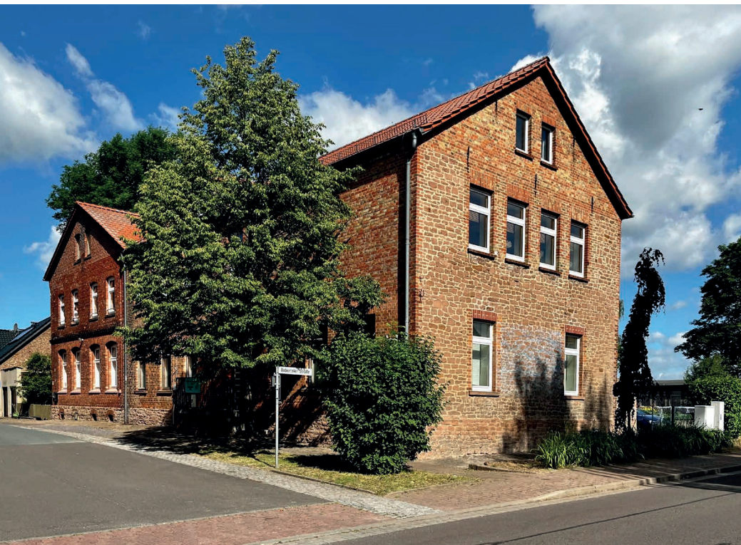
Foto: Coworking Space in der alten Schule in Nordgermersleben / © Tobias Kremkau
