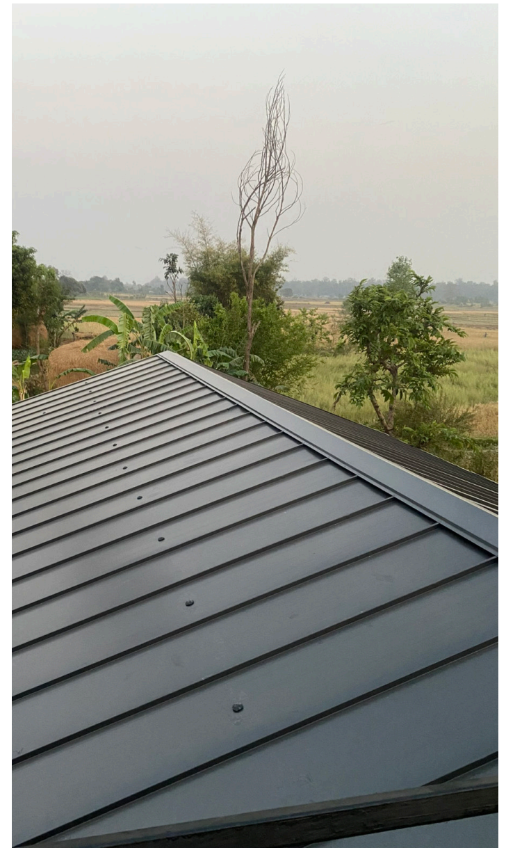
Dachdeckung fertiggestellt Abbildung Bindl Raphael
