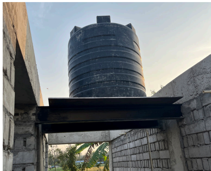
Zisternen Toilettengebäude Abbildung Bindl Raphael
