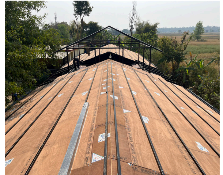
Dachschalung mit Lattung Abbildung Bindl Raphael
