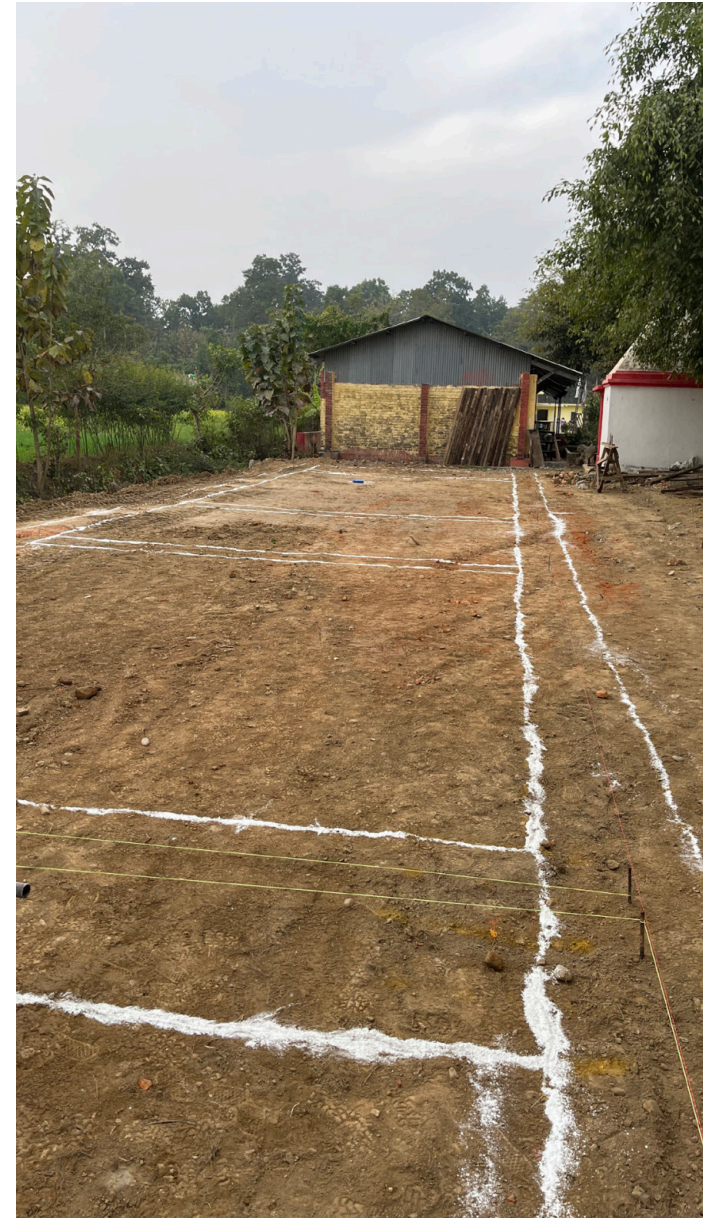
Markierung der Fundamente für den Aushub Abbildung Bindl Raphael
