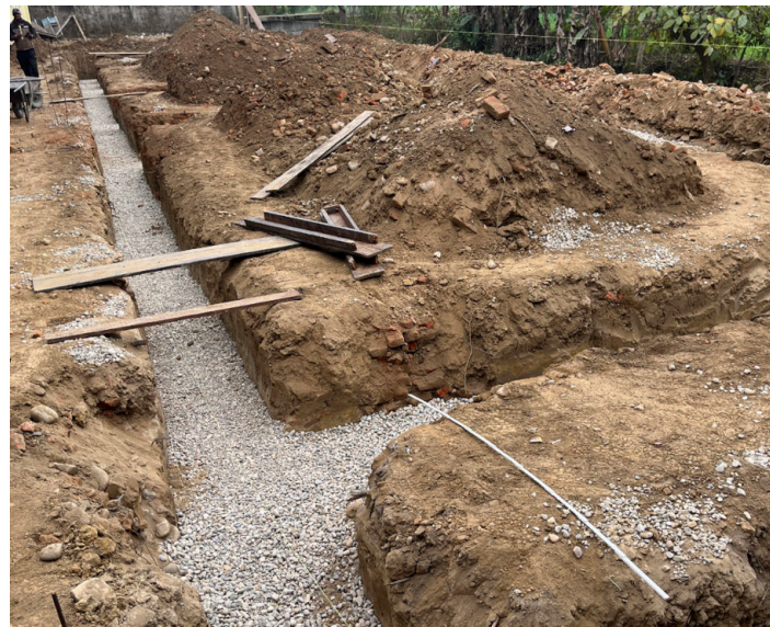
Einbringen Schottersschicht unter der Sauberkeitsschicht Abbildung Bindl Raphael
