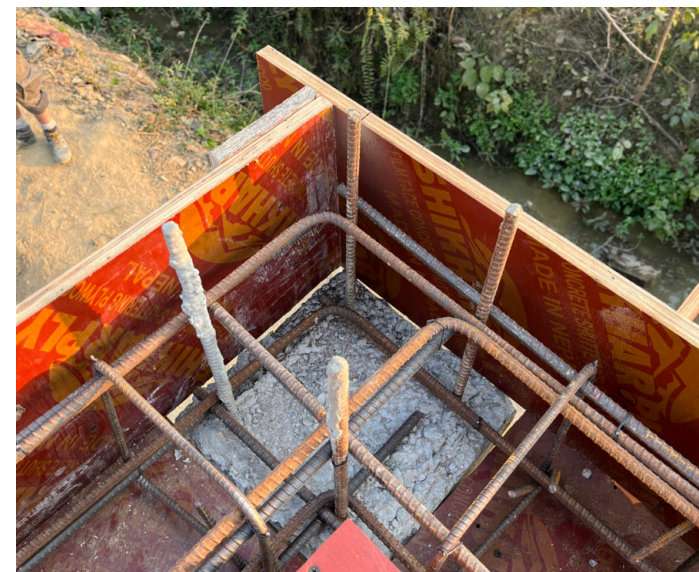
Bewehrung für Ringanker fertiggestellt Abbildung Bindl Raphael
