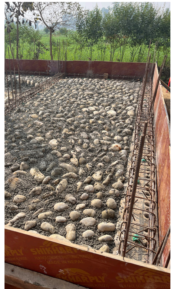
Flusssteine Unterbau der Bodenplatte im Magerbeton Abbildung Bindl Raphael
