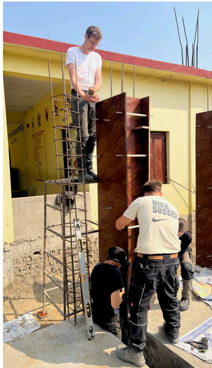
Stellen und Ausrichten der Schalung Abbildung Bindl Raphael
