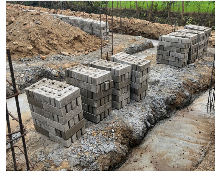
Betonsteine für den Sockel Abbildung Bindl Raphael
