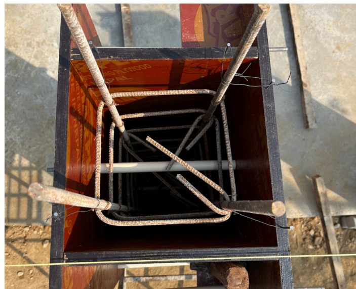
Blick in Stützenschalung Abbildung Bindl Raphael
