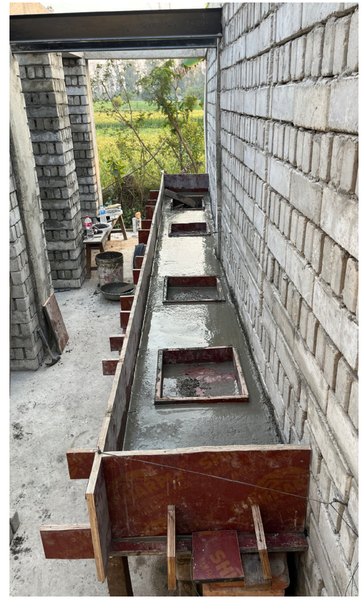
Betonage des Waschtisches Abbildung Bindl Raphael
