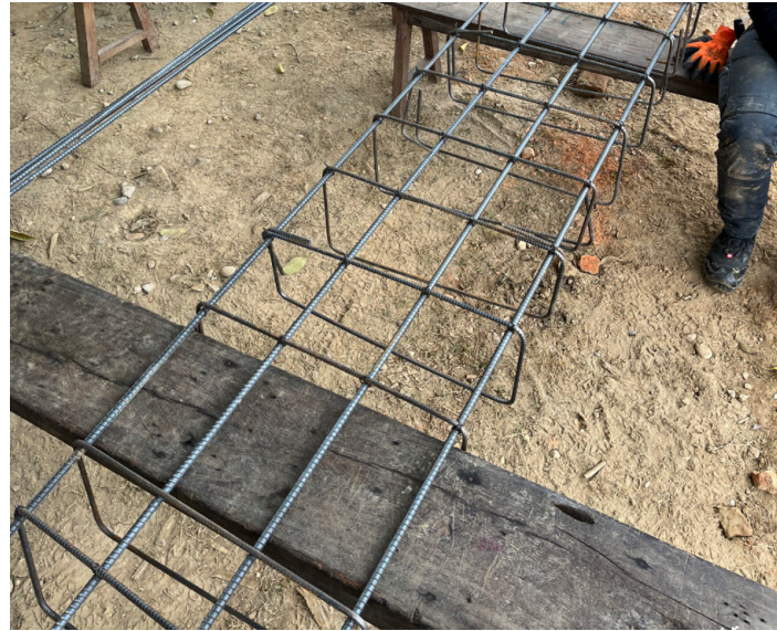
Binden von Bewehrungskörben Abbildung Bindl Raphael
