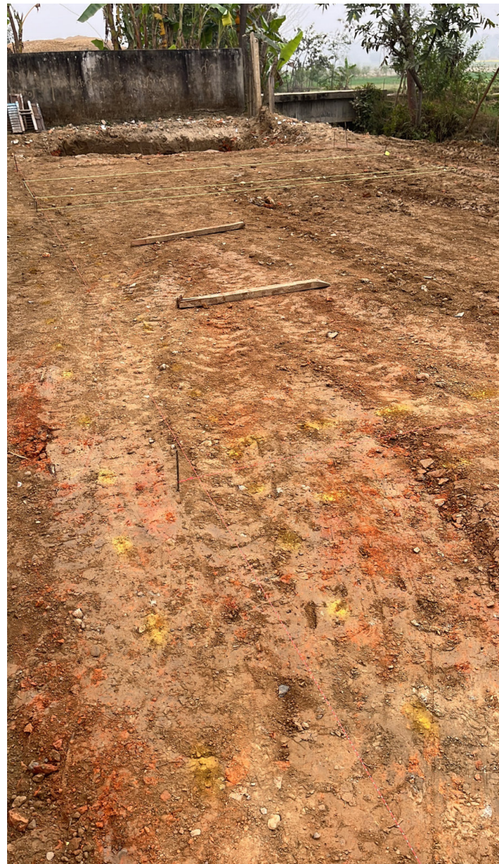
Abstecken der Fundamente Abbildung Bindl Raphael
