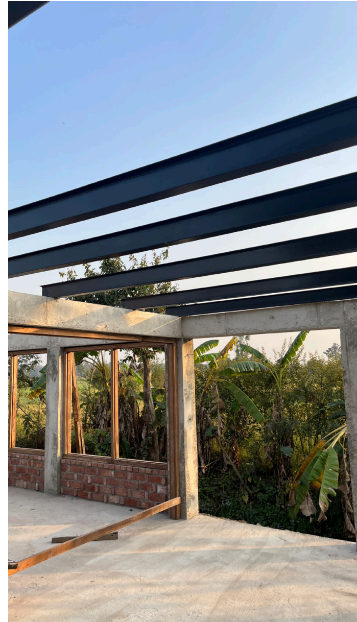
Stahlträger zweite Ebene Abbildung Bindl Raphael
