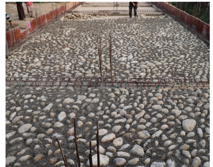
Flusssteine Unterbau der Bodenplatte im Magerbeton Abbildung Bindl Raphael
