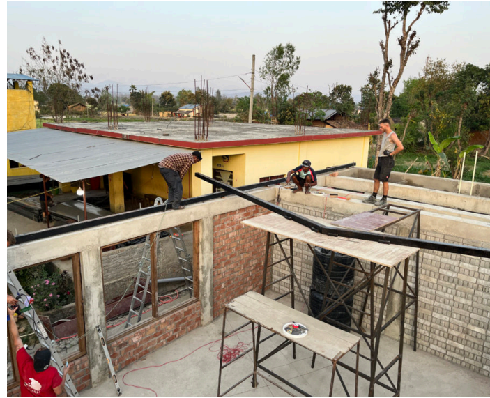
Schweißen des ersten Sparrenpaares Abbildung Bindl Raphael
