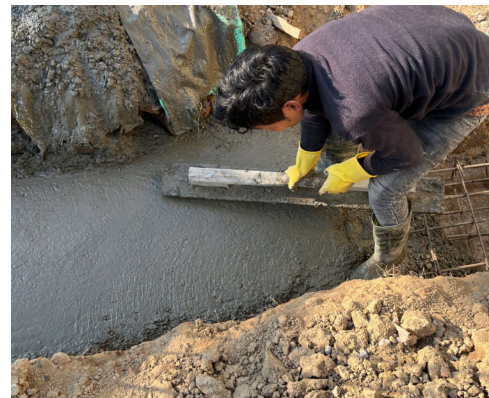
Glätten der fundamente Abbildung Bindl Raphael
