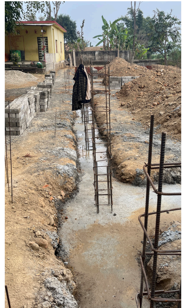
Fundamente vor den Mauern Abbildung Bindl Raphael
