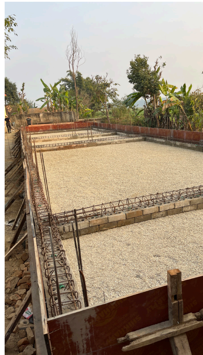
Kiesschicht unter der Bodenplatte mit Plinth-Beam Bewehrung Abbildung Bindl Raphael
