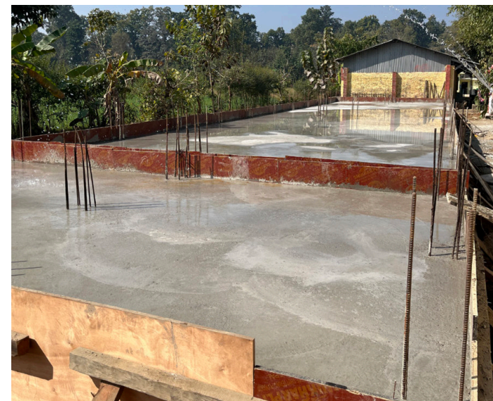
Bodenplatte betoniert Abbildung Bindl Raphael
