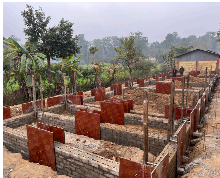
Stützenschalung im Sockelbereich Abbildung Bindl Raphael
