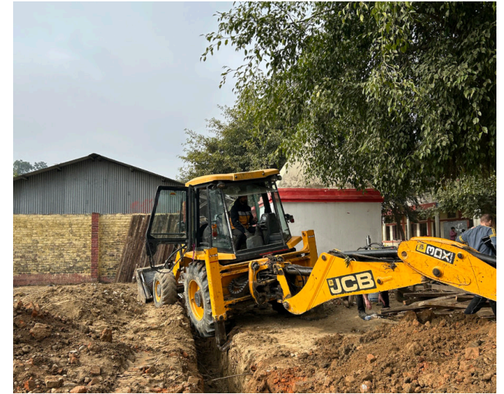
Bagger für den Aushub der Fundamente Abbildung Bindl Raphael
