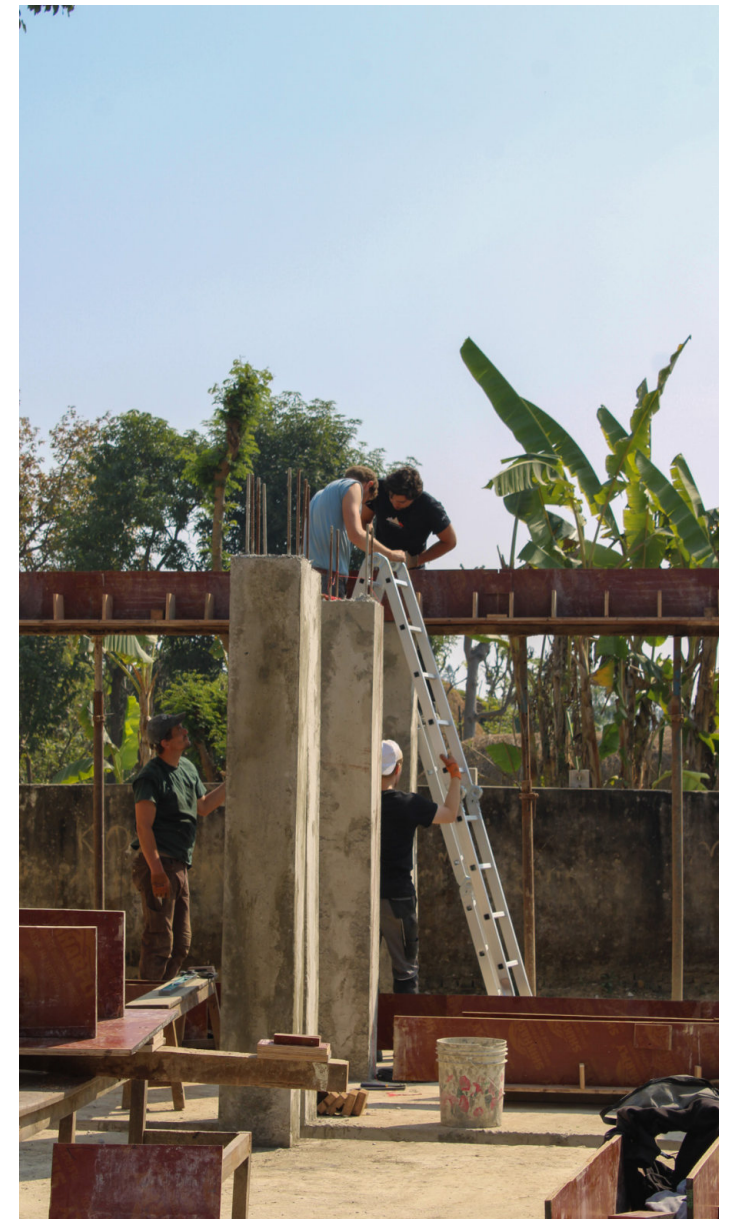
Stellen der Schalung für den Ringanker Abbildung Bindl Raphael
