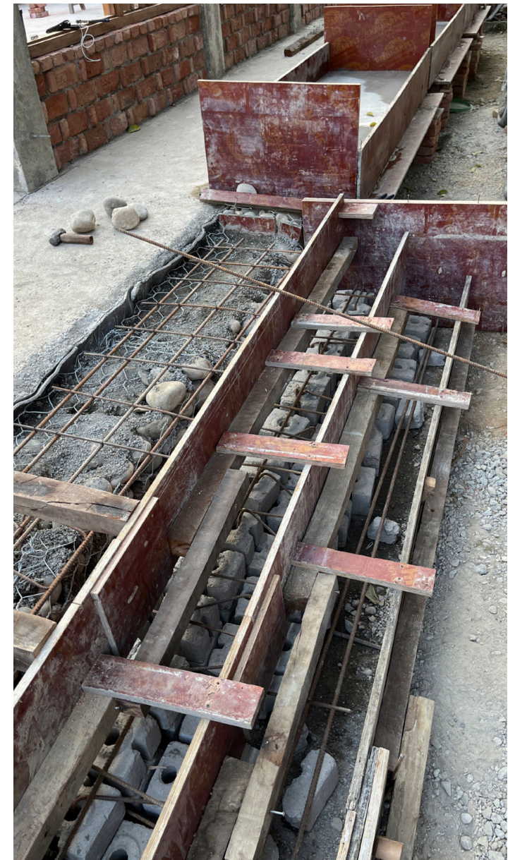
Schalung Haupteingang Treppe Abbildung Bindl Raphael
