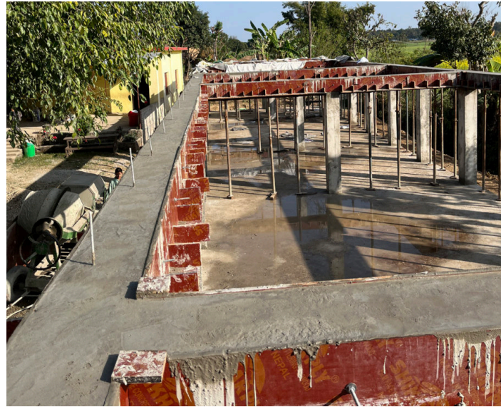
Betonage Ringanker abgeschlossen Abbildung Bindl Raphael
