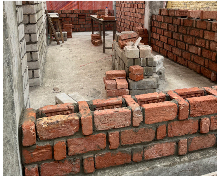
Mauerwerk 2-schalig Abbildung Bindl Raphael
