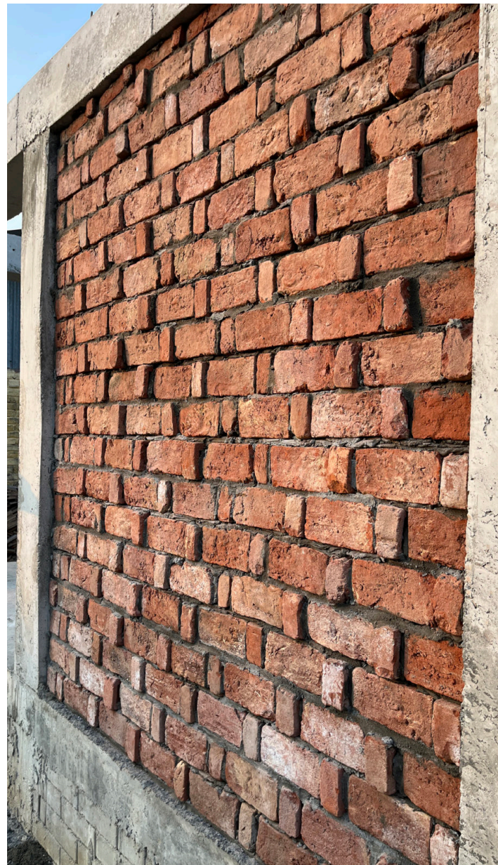
Sichtmauerwerk Abbildung Bindl Raphael
