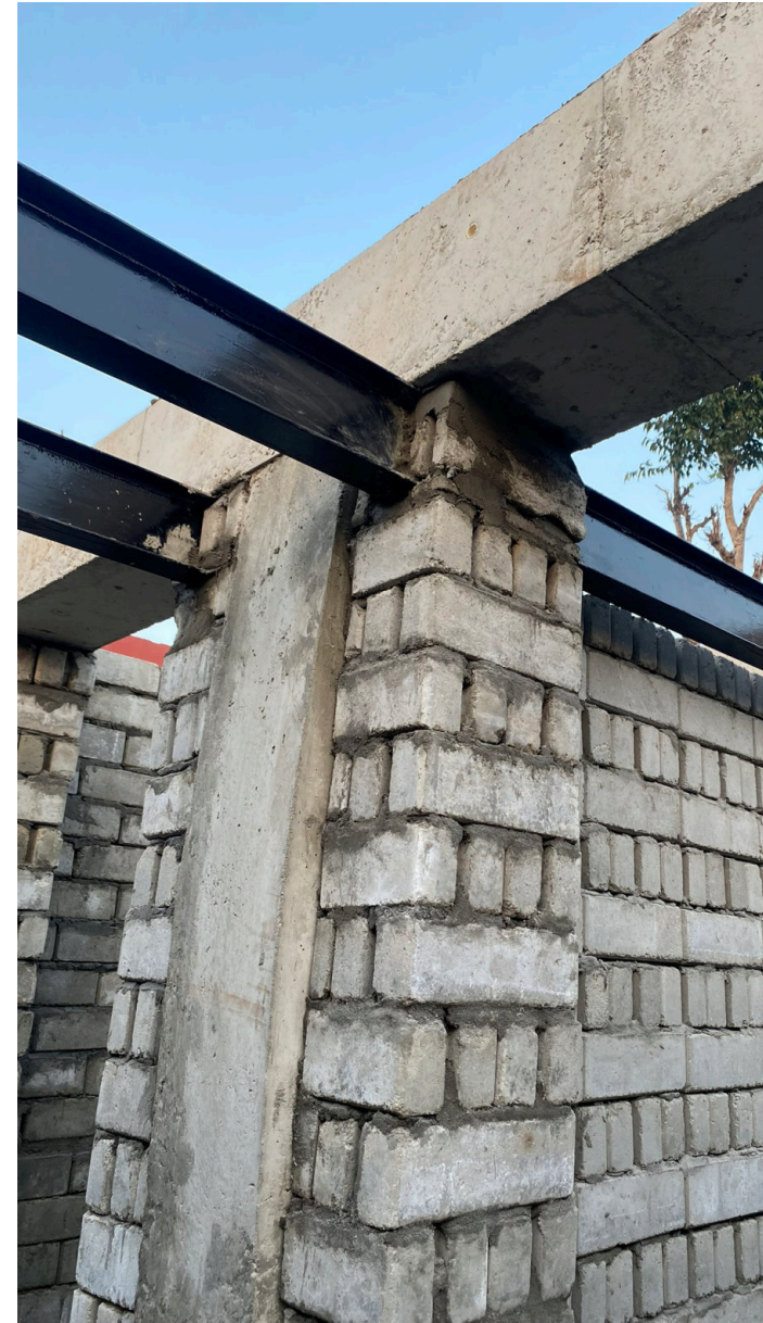
Einbau Stahlträger Zisternen Toiletten Abbildung Bindl Raphael
