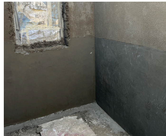
Verputzen der Toiletten Abbildung Bindl Raphael
