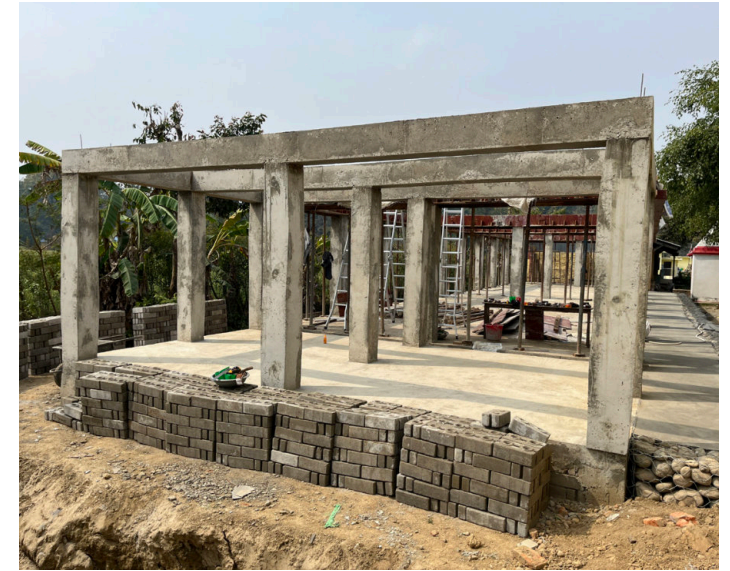
Beginn Mauerarbeiten Toiletten Abbildung Bindl Raphael
