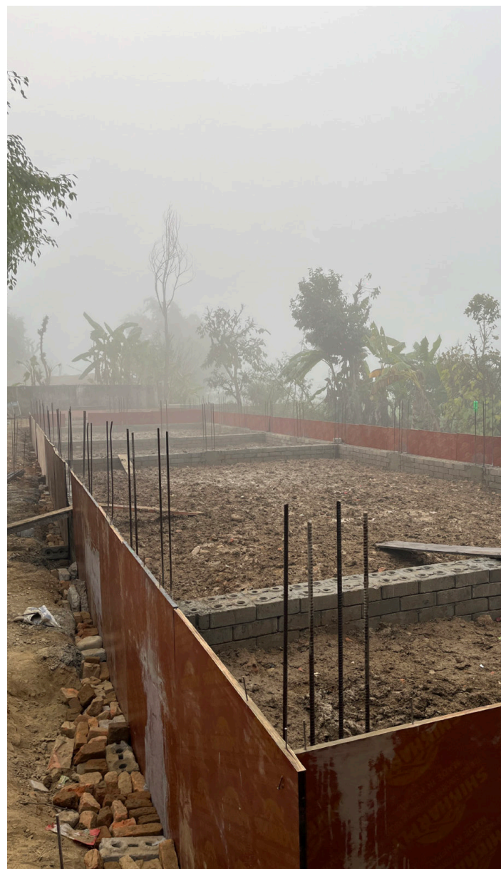
Schalung Bodenplatte noch nicht abgestützt Abbildung Bindl Raphael
