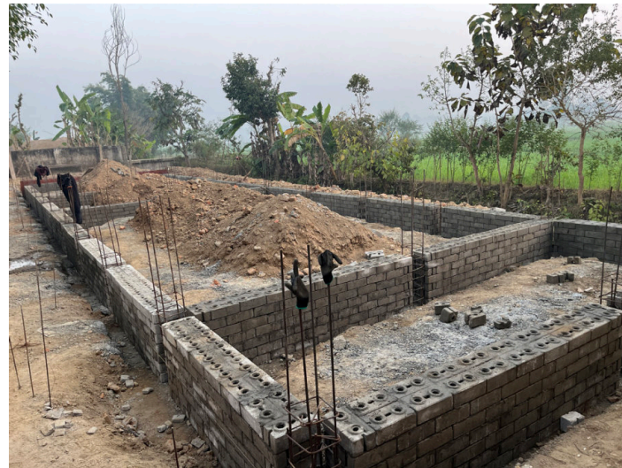
Fertigstellung Sockelmauern Abbildung Bindl Raphael
