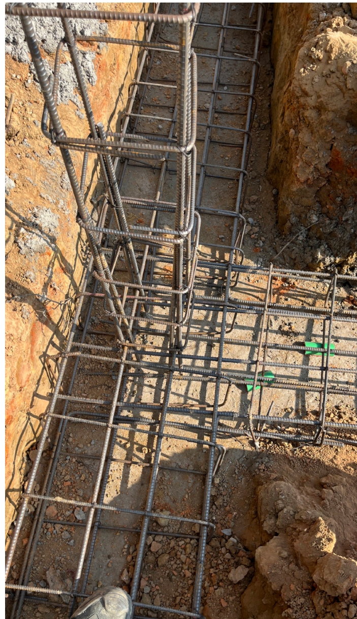
Einbinden der Stützen mit Eckzulage Abbildung Bindl Raphael
