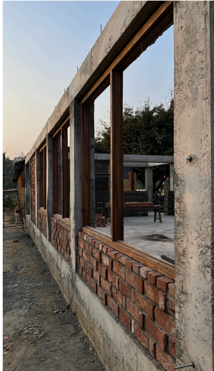
Fensterrahmen eingebaut Abbildung Bindl Raphael
