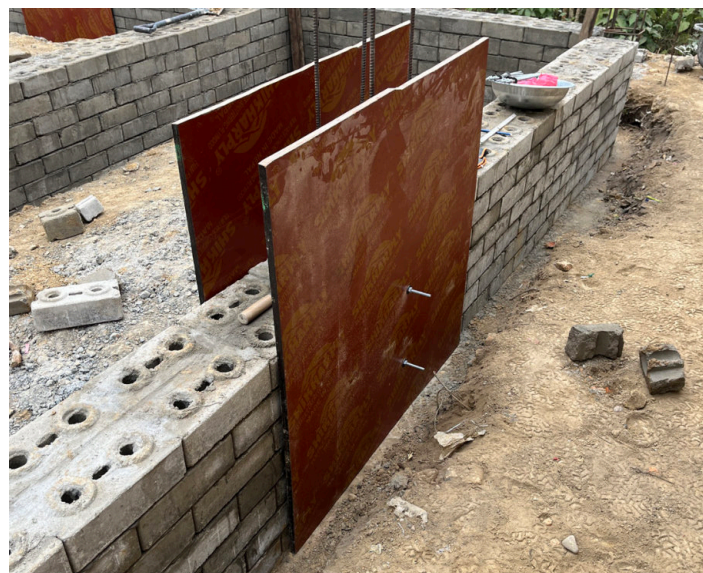
Stützenschalung im Sockelbereich Abbildung Bindl Raphael
