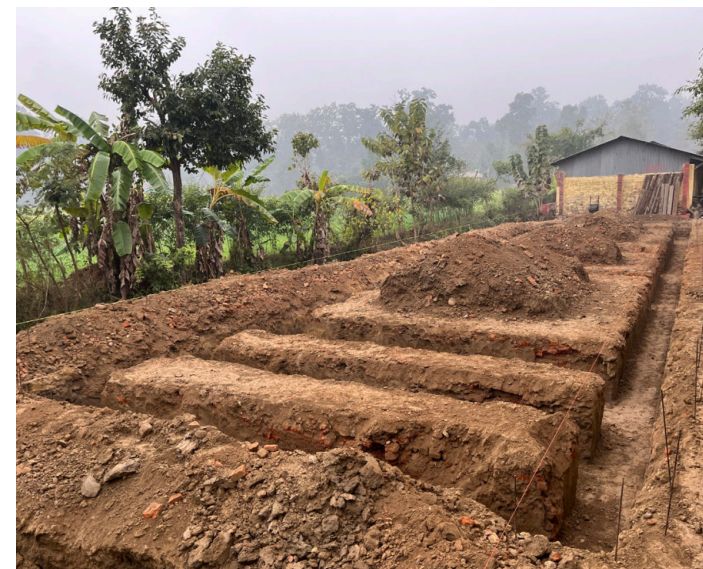
Fundamente fertig ausgehoben Abbildung Bindl Raphael
