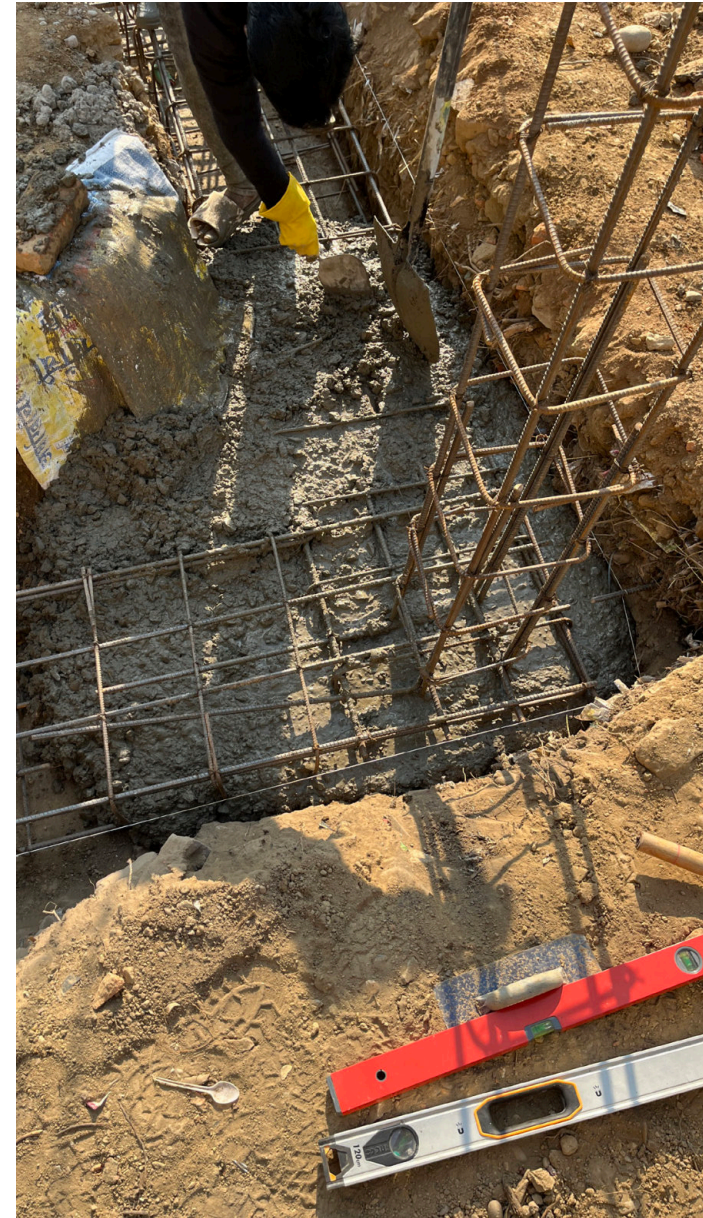
Betonage der Fundamente Abbildung Bindl Raphael
