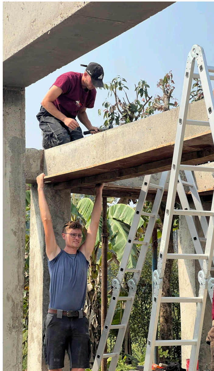
Ausschalen des Ringankers Abbildung Bindl Raphael
