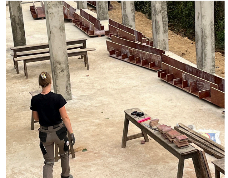
Schalungsbau Ringanker / Recycling Stützenschalung Abbildung Bindl Raphael
