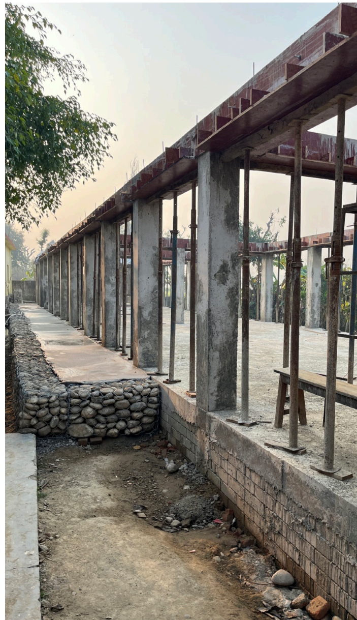
Schalung Ringanker Abbildung Bindl Raphael
