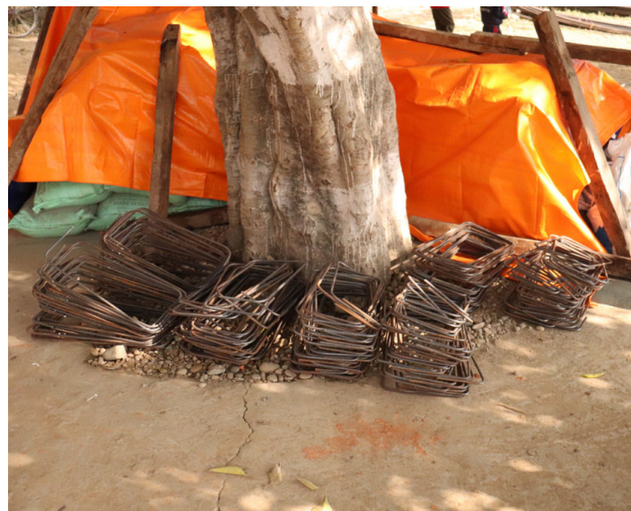
erste Bewehrungsbügel gebogen Abbildung Bindl Raphael
