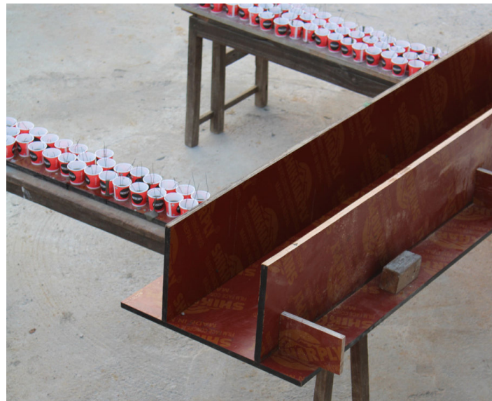
Selbstgebaute Schlung für die Stützen Abbildung Bindl Raphael
