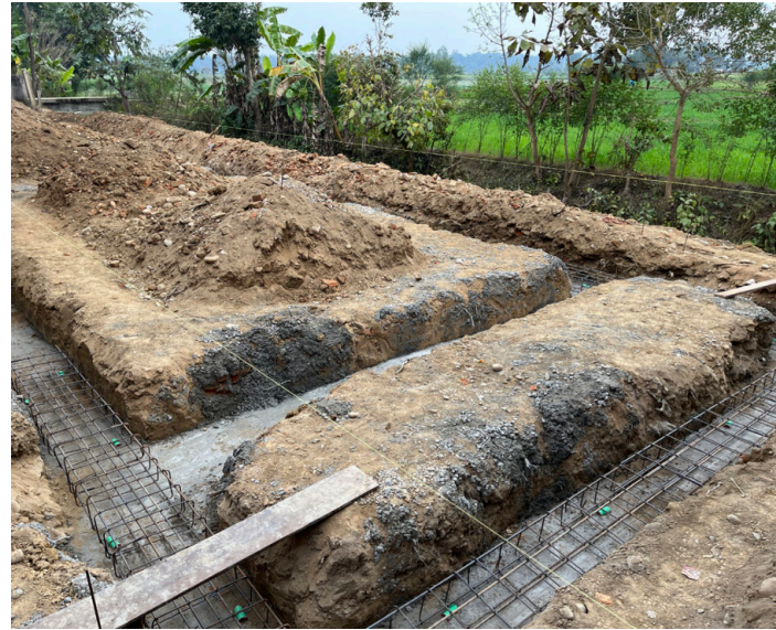
Einlegen der Bewehrungskörbe Abbildung Bindl Raphael
