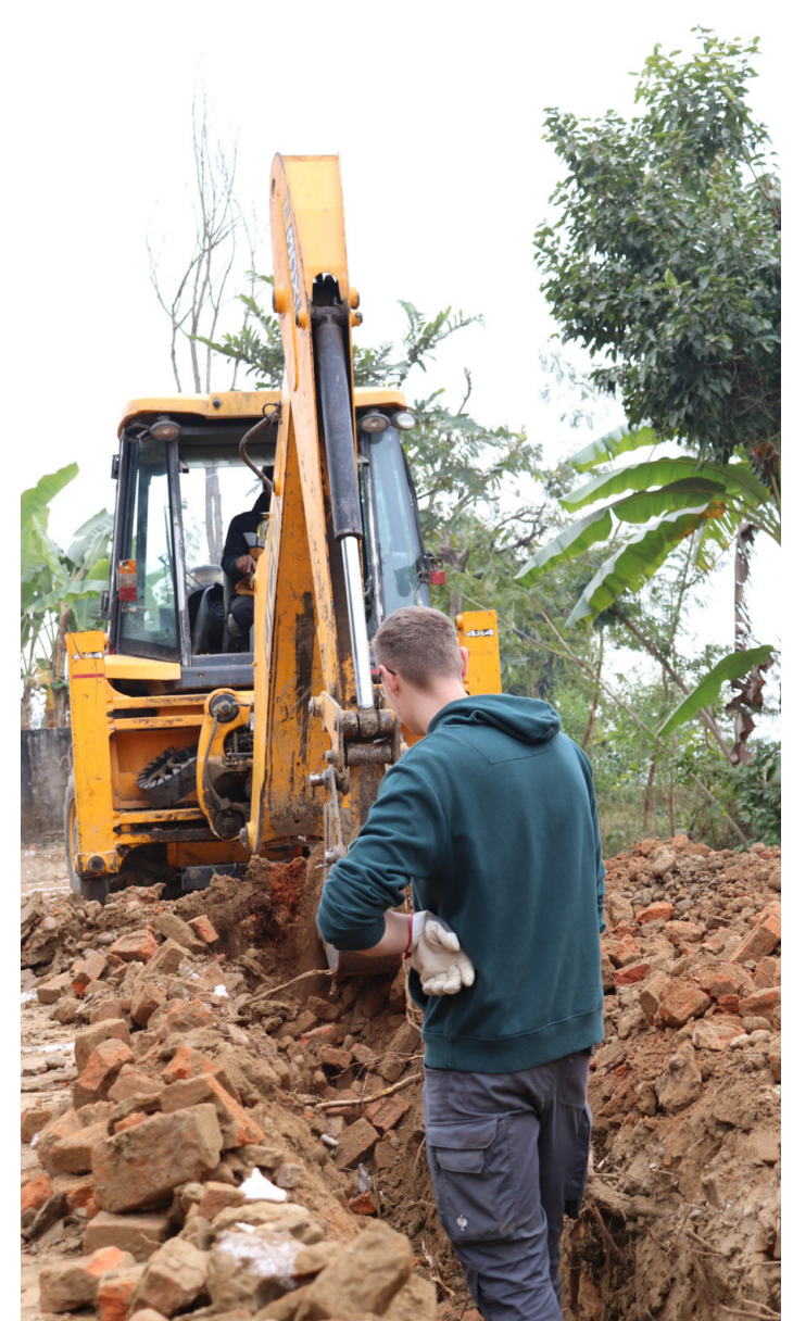
Aushubarbeiten für die Fundamente Abbildung Bindl Raphael
