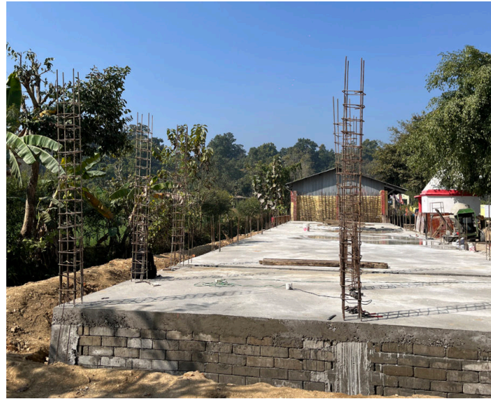
Bodenplatte ausgeschalt und Stützenbewehrung angebunden Abbildung Bindl Raphael
