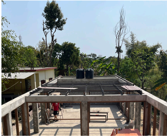
Setzen der ersten Fußpfetten Abbildung Bindl Raphael
