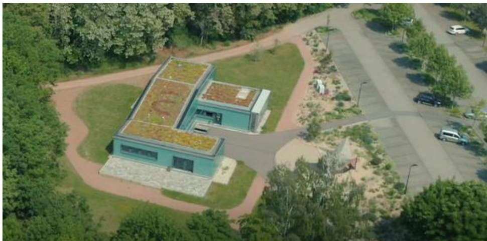
Abb. 4: Dachbegrünung der Innovationswerkstatt Campus Bernburg im Juni 2021 (Luftbildaufnahme erstellt von Vorlautfilm im Auftrag der Hochschule Anhalt)
