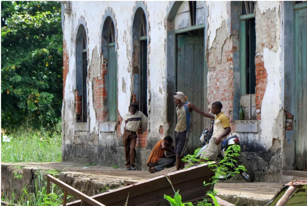
In den Ruinen zahlreicher alter Kolonialgebäude leben noch immer Menschen
